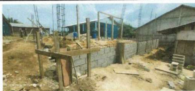
Foto 4: Estructura de techo y cubierto de lamina
