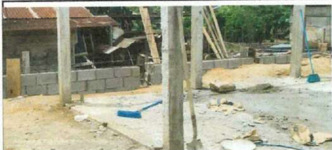
Foto 3: Sustitucion de piso de concreto
