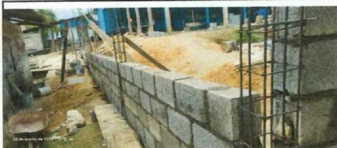
Foto 5: Fundicion de columnas y mojinetes
