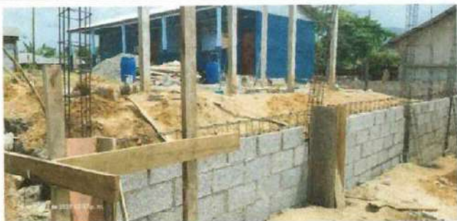
Foto1: Fundicion de soleras de intermedia.
